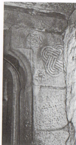
Dettaglio dello stipite e del concio d'imposta in un portale di un articolato organismo architettonico ad attuale destinazione rurale. Si riconoscono alcuni simboli dei lapicidi, diffusi in diverse aree dell'appennino emiliano-romagnolo e riconducibili a maestranze di tradizione lombarda. In particolare si noti il 'nodo gordiano' o 'nodo di Salomone' e le 'rose' a struttura geometrica esagonale e pentagonale. Castel d'Alfero (Sarsina)
