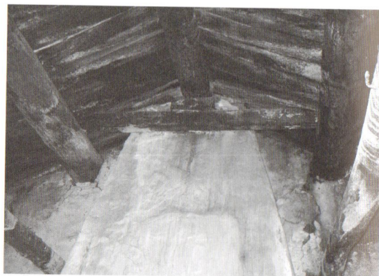
Dettaglio della copertura in lastre di arenaria in una casa rurale lungo le pendici di Monte Marino (Bagno di Romagna).
