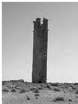
La Torre dello stilita ad Umm er Rasas.
