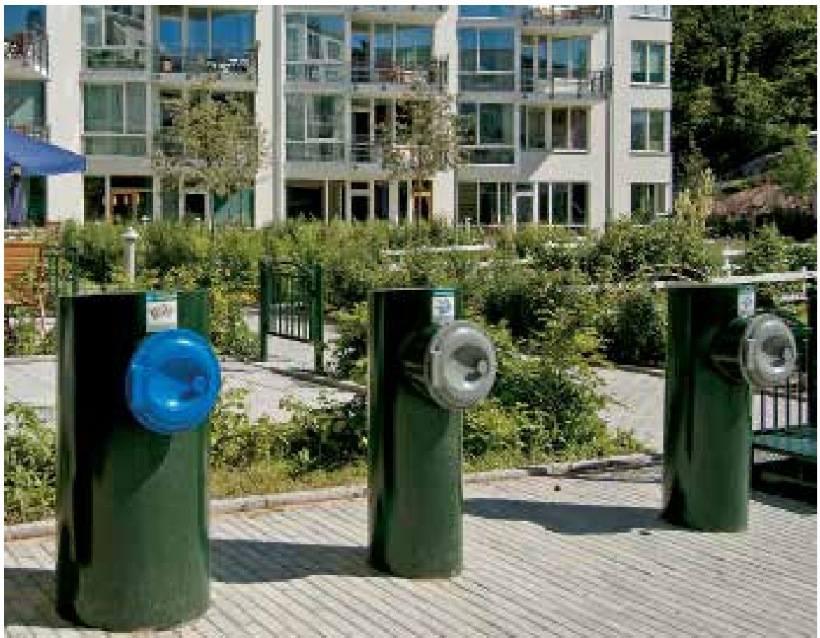
(Immagine n. 125b) Raccolta differenziata Envac all'Hammarby Sjöstad, quartiere di edifici a basse emissioni di carbonio a Stoccolma
