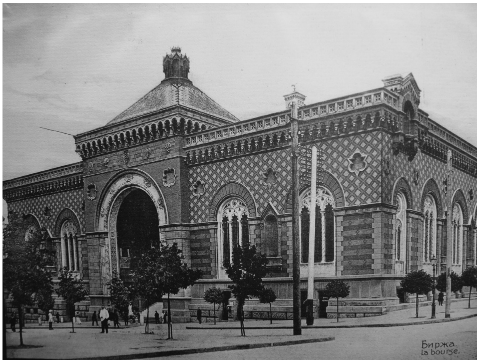
Fig. 1 - Fronte principale della Filarmonica di Odessa (ex Borsa)
