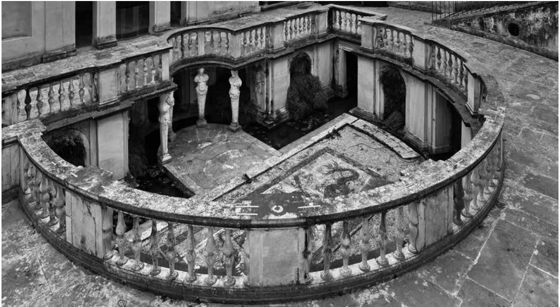
12. Loggia dell'Ammanati, 1553-1554, Roma, Villa Giulia, particolare della balastrata
