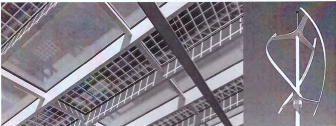
Figura 5. Copertura dell'auditorium con lucernari integrati moduli micro eolico per le residenze.
