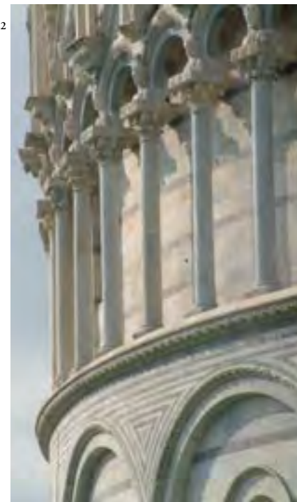
Fig. 20 - Particolare della galleria esterna del secondo ordine della facciata, lato nord.
