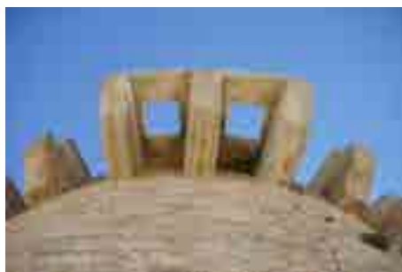
Fig. 7- Guirnalda. Torre de Piles.
