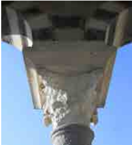
Fig. 3- Santissima Trinità di Saccargia Basilica (Codrongianos, north Sardinia): a capital of limestone in advanced state of decay.
