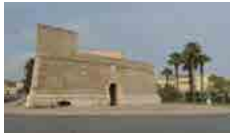
Fig. 4– Bastione di Sant’Antonio, lato Porta a Mare.
