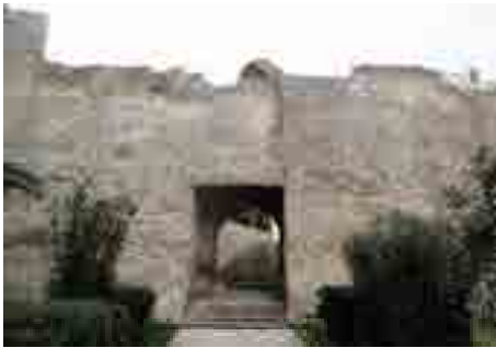
Fig. 8- Vista d'ingresso nel muro in direzione SO, Fortezza di Durazzo (Foto di Andia Guga, 2016).
