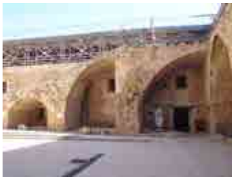
Fig. 2– veduta del cortile della cittadella di Acri.
