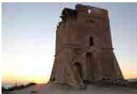
Fig. 4- Vista est della torre di Manfria.
