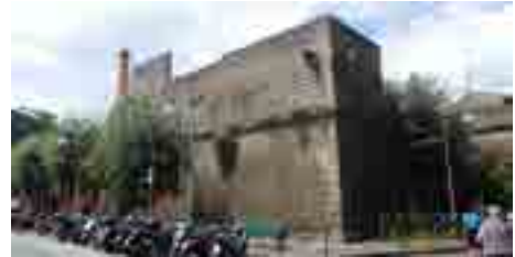
Fig. 6 – Sorrento. Sant'Antonino bastion.
