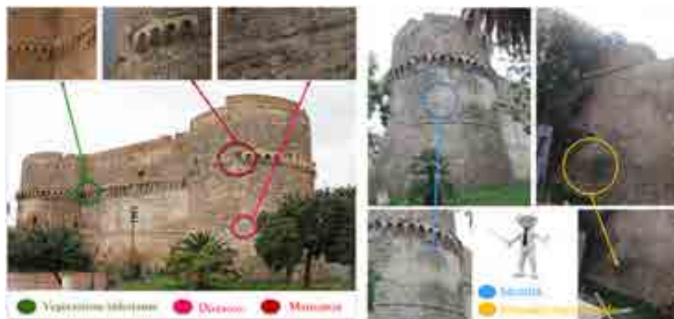
Fig. 6 - Principali patologie di degrado individuate (a, b).
