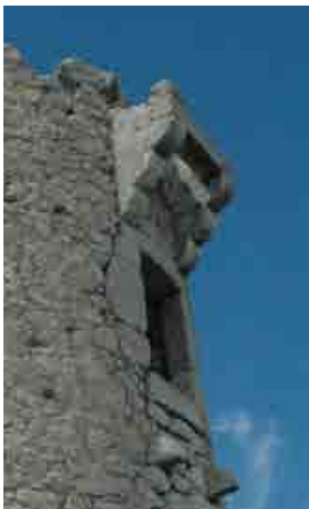
Fig. 6- Matacán tipo ladronera sobre acceso elevado. Torre Ebri (Alcalá de Xivert).
