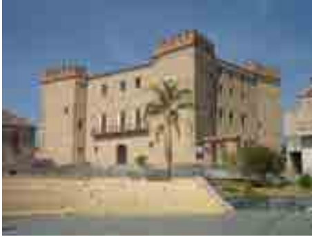
Fig. 2b- Castello di San Lorenzo del Vallo dopo il restauro.
