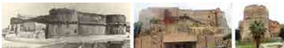
Fig. 4- Il Castello: immagine storica (a); prospetto posteriore (b); prospetto ala destra (c).
