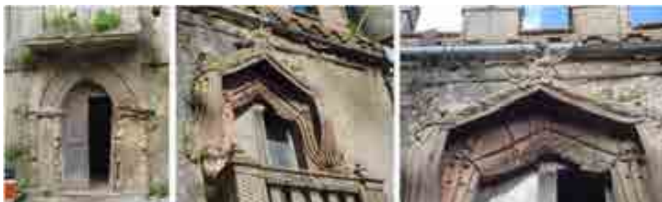
Fig. 3- Particolare delle decorazioni in rilievo che incorniciano la porta finestra.
