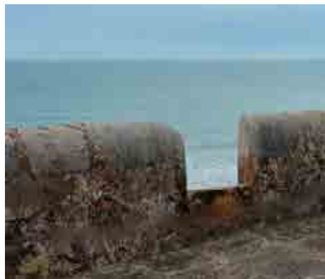
Fig. 8- Parapeto con cañonera. Torre S. Vicent (Benicassim).
