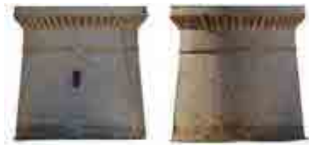
Fig. 11- Alzados fotogramétricos de la torre (TOVIVA Project, 2016).
