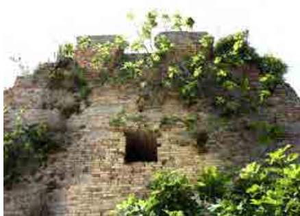
Fig. 4- Torre Mucchia. Prospetto S: dettagli.
