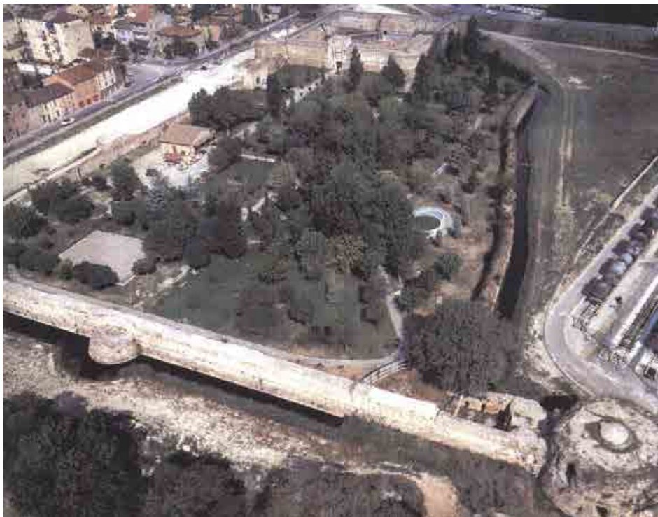
Fig. 10- La Rocca Brancaleone, a destra il cosiddetto torrione della ghiacciaia, preesistente alla rocca e trasformato dai veneziani in baluardo. (IBC, C. FANTI).
