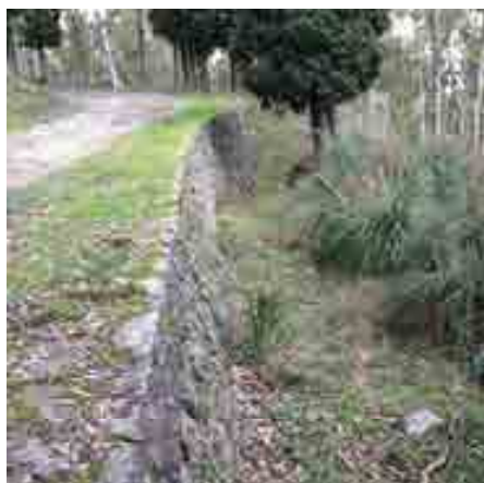
Figura 10- Muro di “controscarpa” della strada militare Pizzo Chiarino - Forte Campone, Messina.
