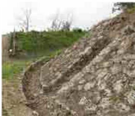
Figura 4- Cunetta di raccolta. Forte S. Jachiddu, Messina.
