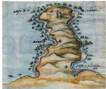
Fig. 3- Indicazioni, contrassegnate dalle croci, per il posizionamento di due torri a Capo Colonne (KR).
