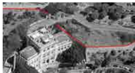
Fig. 9- Profilo attuale del tenaglione della Concezione e percorso che lo interrompe.
