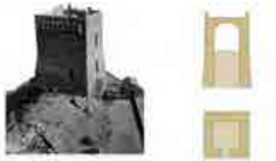
Fig.9a- Tower of the Giraglia, 1571, Capo Corso.
