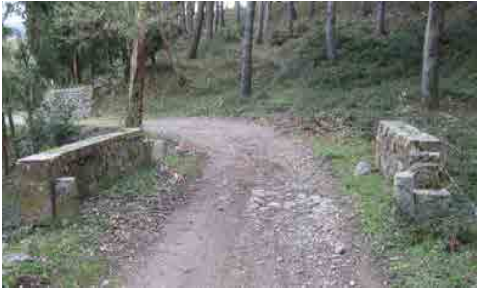
Figura 6- Ponte e Sottoponte per lo scorrimento dell'acqua piovana.
