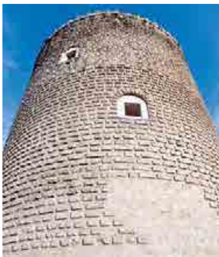
Fig. 2- Bitonto, Torrione. In evidenza il paramento murario bugnato.
