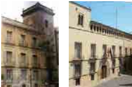
Fig.3- Torre de defensa del palacio de Cervelló antes de su intervención y torre de defensa del palacio de Scala.
