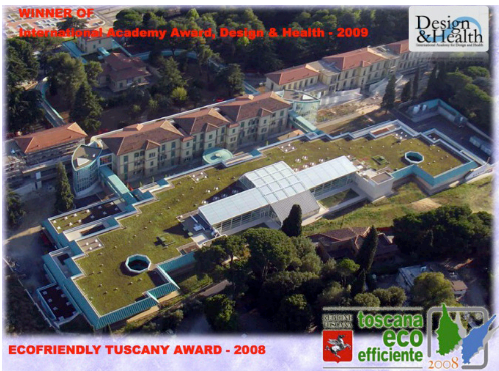
08 | L'ospedale pediatrico Meyer a Firenze: ristrutturazione ed ampliamento di Villa Ognissanti Meyer children Hospital in Florence: refurbishment and expansion of Villa Ognissanti
