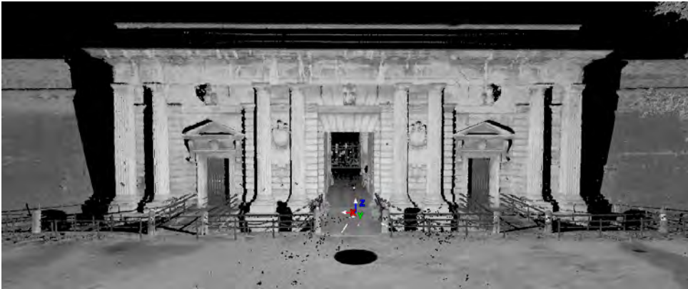
Fig. 7- Veduta della nuvola di punti di una singola scansione posta all'ingresso di Porta Palio.
