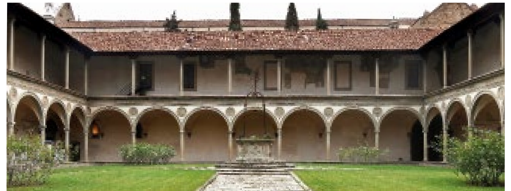
2. Veduta del chiostro quattrocentesco del convento di Santa Croce.
