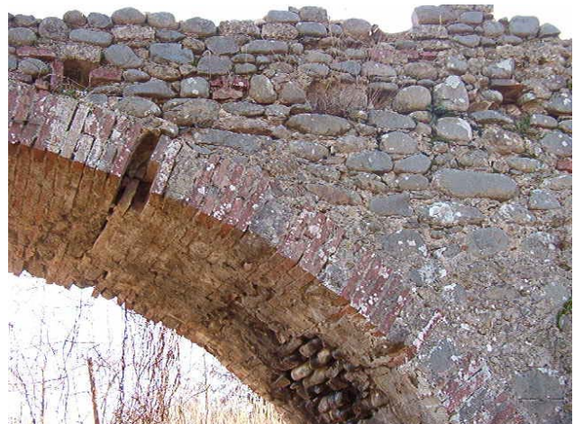
Fig. 5 - Ponte alla Vergine. Spandrel face
