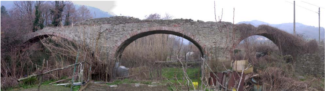
Fig. 3 - Ponte alla Vergine. Complete front view.
