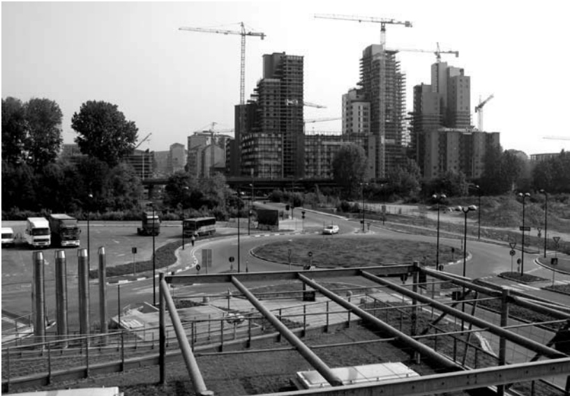
4. Foto degli edifici della Spina 3 in costruzione
