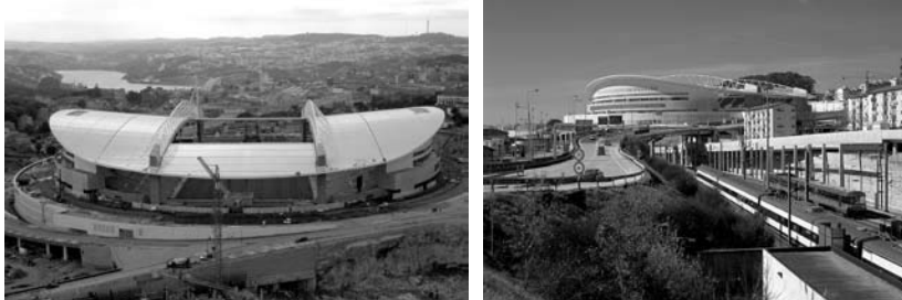
6. Porto, il Douro e lo Stadio Dragão; lo Stadio Dragão e le infrastrutture della mobilità
