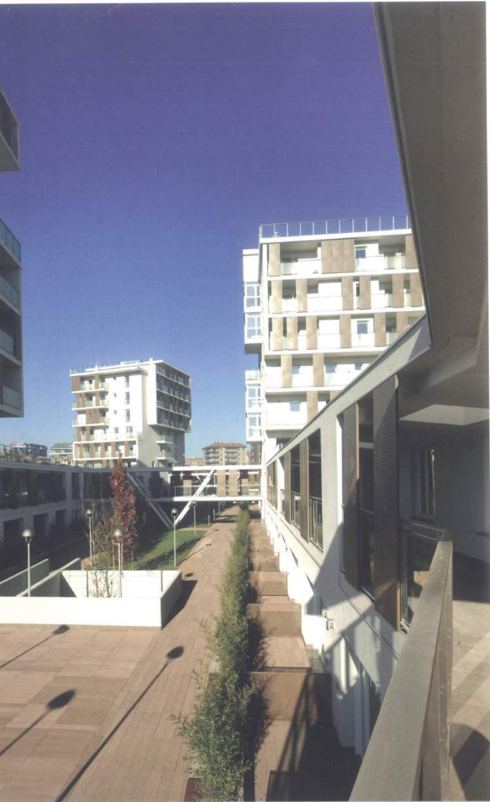
9 Vista dal ballatoio View from the gallery
