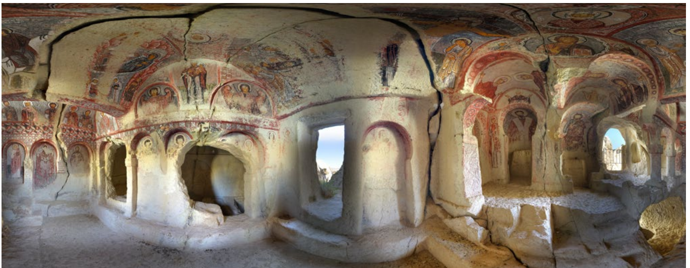
Immagine equirettangolare dell'interno della chiesa di Maryem Ana a Göreme (Turchia). E' possibile notare come l'intera struttura sia interessata da una profonda frattura che ne compromette la stabilità.
