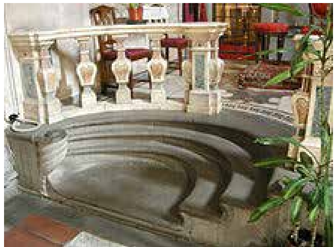
Fig. 110-111-112: navata della Chiesa di S.Egidio e particolare della scala absidale inserita all'interno della chiesa intorno al 1580. La scala di Sant'Egidio è del tutto simile alla scala inserita nel coro e altare maggiore di Santa Trinita, adesso in Santo Stefano al Monte, dove è molto evidente l'alternanza di parti convesse.
