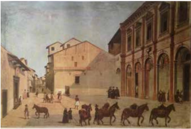
Fig. 79: Ignoto (seconda metà del secolo XVII), viene testimoniata l'assenza della parte sinistra del loggiato costruita negli anni 1961-1963.
