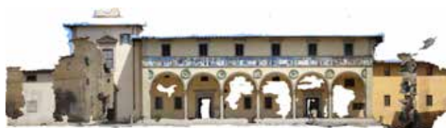
Fig. 143-144-145-146-147-148 (dall'alto verso il basso): rilievo fotogrammetrico dell'altare maggiore della Chiesa di Sant'Egidio, e Ortofoto piano ottenuto dall'elaborazione tramite il software Photoscan. Rilievo fotogrammetrico del loggiato dell'Ospedale del Ceppo di Pistoia e restituzione dell'ortofoto della facciata sud elaborata tramite il software Photoscan. Quest'ultimo modello è stato utilizzato per le restituzioni piano-altimetriche del loggiato al fine di studiarne le misure e confrontarle con i risultati ottenuti nel loggiato di Santa Maria Nuova; il tutto come meglio esplicitato nei capitoli successivi.
