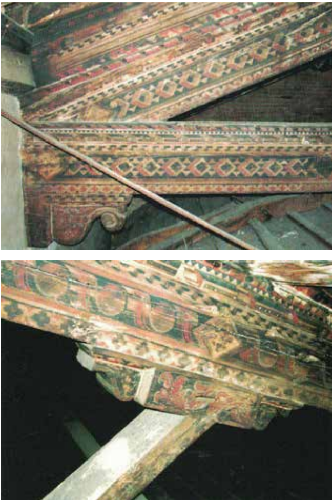
Fig. 33-34 (da sinistra a destra): particolare del puntone, catena e mensola di una capriata, dipinta con prevalenza di cubi prospettici e girali; attacco fra saetta e puntone con gattello a doppia mensola; (L.Giorgi, P.Matracchi, in Ghidetti, Diana; pp. 554-555)
