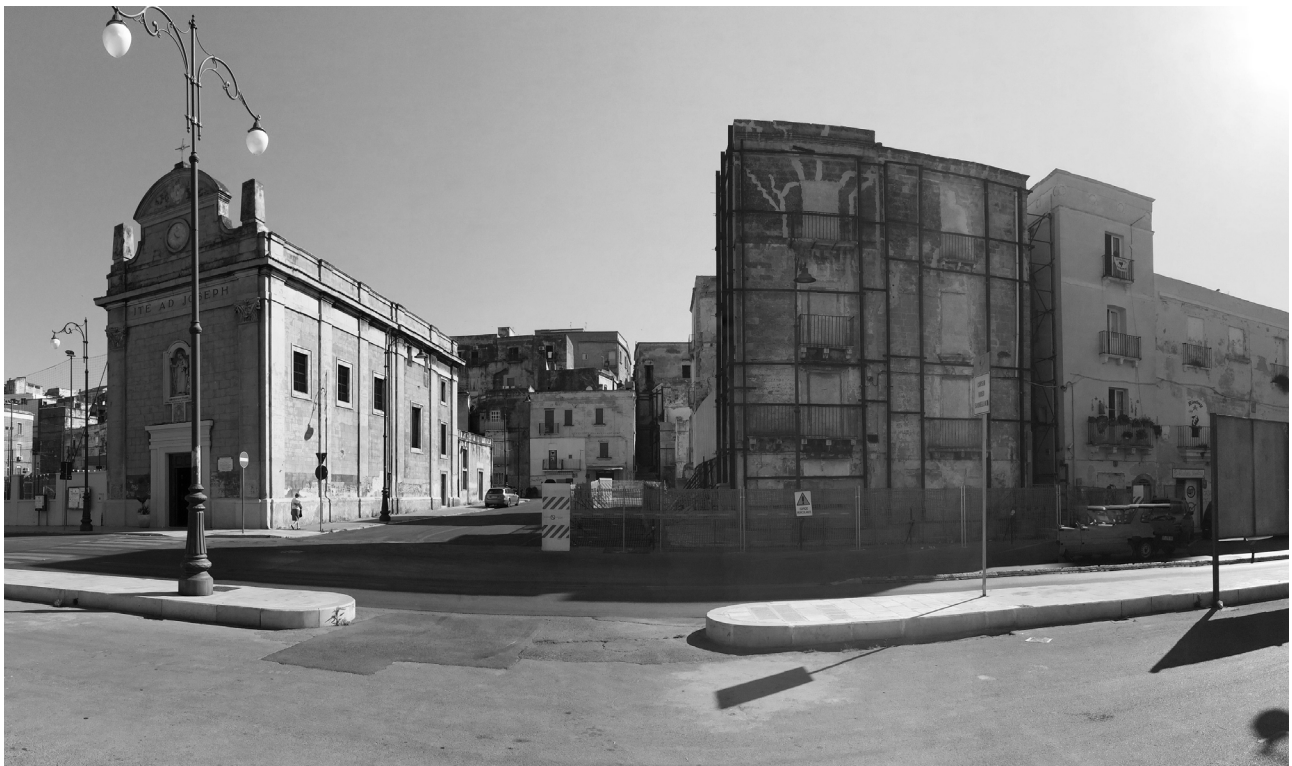
Fig. 5: Via Garibaldi, dopo il crollo del novembre 2014.
