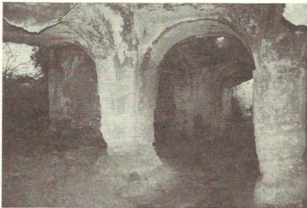
Figura. 3. L'aula ripresa da sud-ovest. Sono evidenti i due pilastri residui fortemente consunti alla base, nonché l'abbassamento del piano di calpestio.
