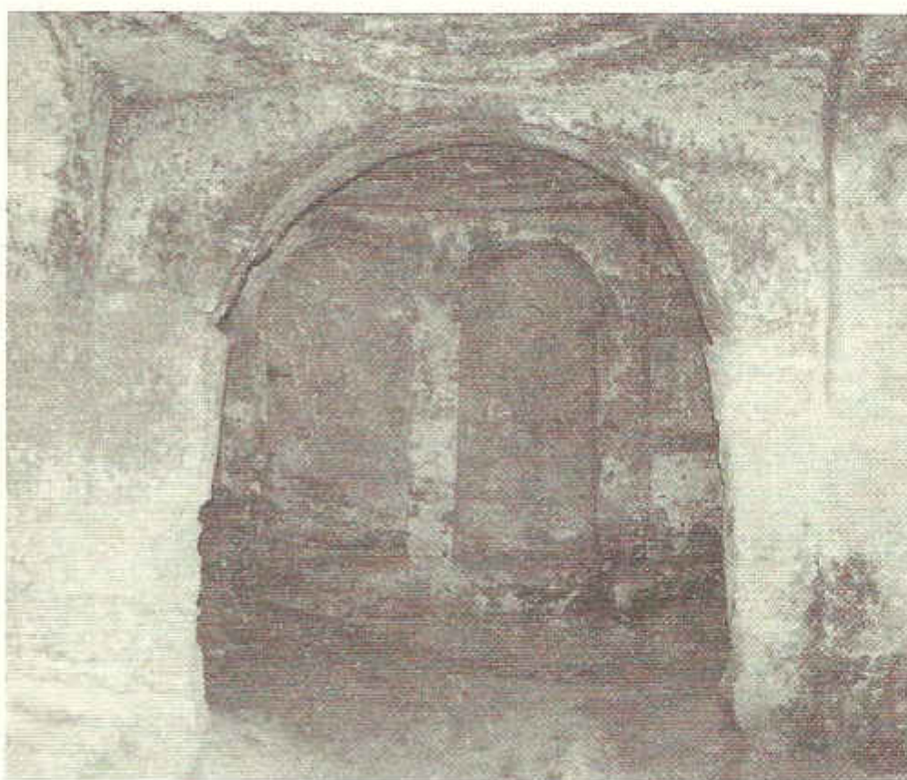
Figura. 4. Il lato nord dell'aula con due delle tre nicchie originariamente presenti sulla parete. Al soffitto è possibile leggere i cerchi concentrici della pseudo-volta. Il piano di calpestio appare fortemente usurato e, in alcuni punti, intenzionalmente ribassato.
