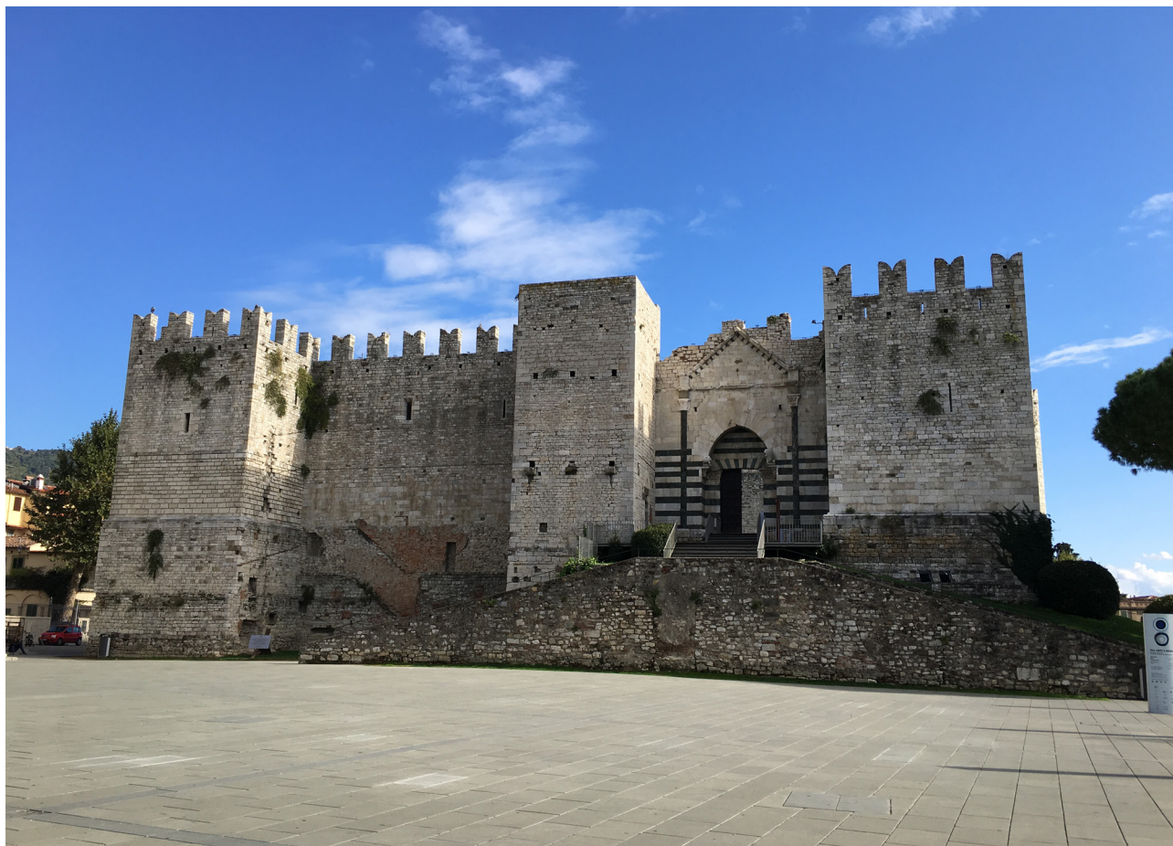
Fig. 1. Il Castello dell'Imperatore di Prato, prospetto principale.
