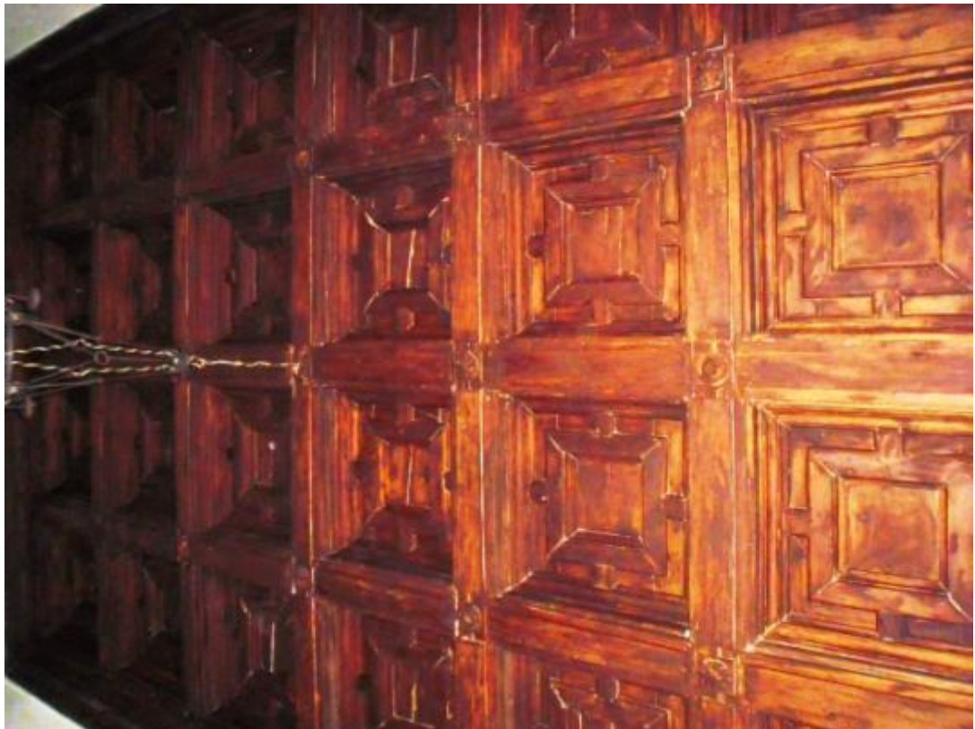
Figura XII.5: soffitto a cassettoni della stanza adiacente alla loggia decorata nella Canonica di San Martino a Montughi, Firenze.
