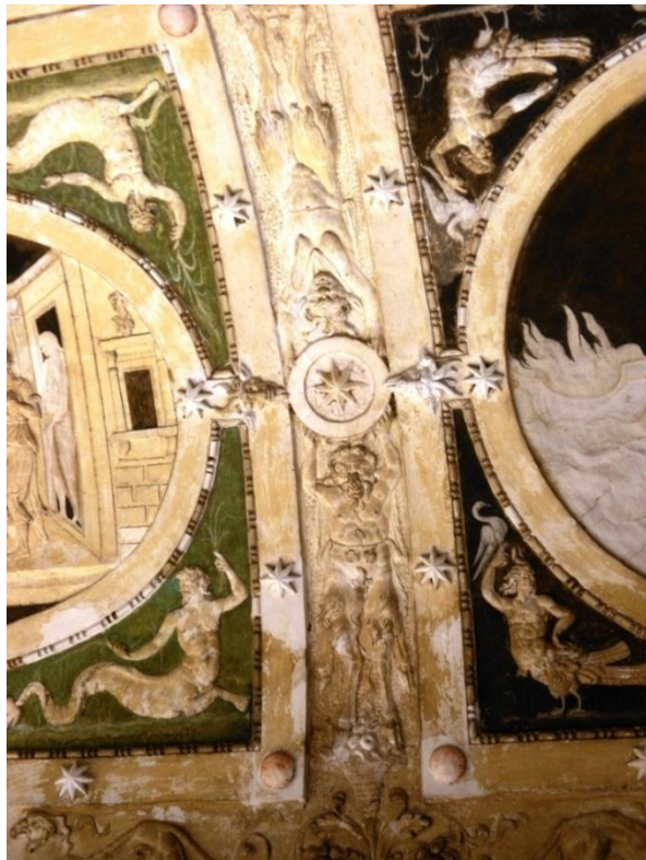
Figura XII.7: S. Cosini (attr.), particolare delle cornici della volta della loggia della Canonica di San Martino a Montughi, Firenze, ca. 1539.
