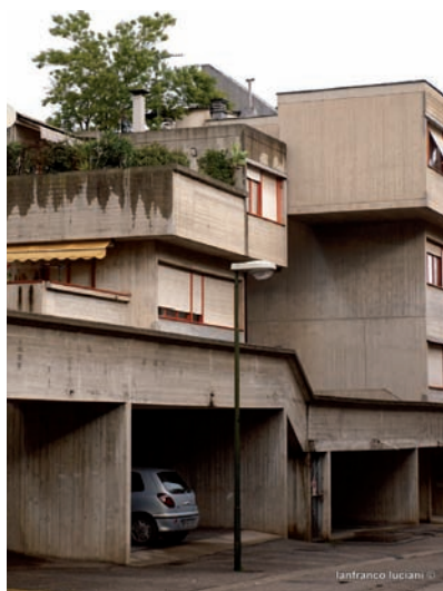
Giancarlo De Carlo, Nuovo Villaggio Matteotti, Terni, 1970-1975 (rif. 169, 170)
