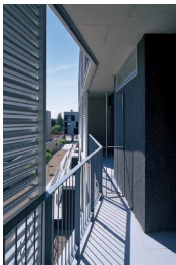
Magen Arquitectos, 68 Social Housing, Zaragoza, 2002-2006 (rif. 150, 151)
