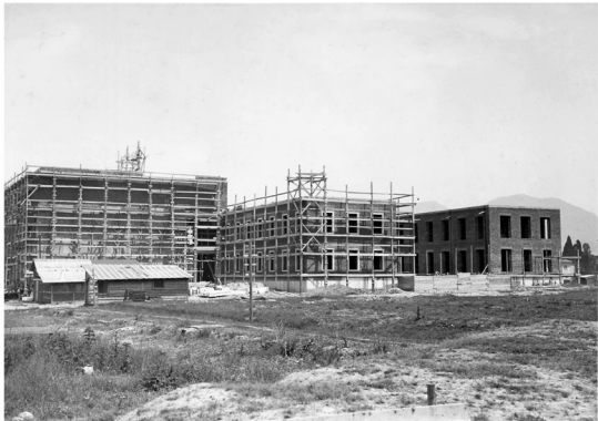
Edificio Uffici Luogotenenziali in costruzione, 1939/40. Foto d'epoca
