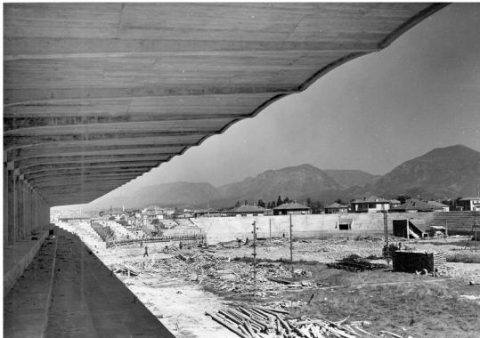
Stadio in costruzione, 1939/40. Foto d'epoca
