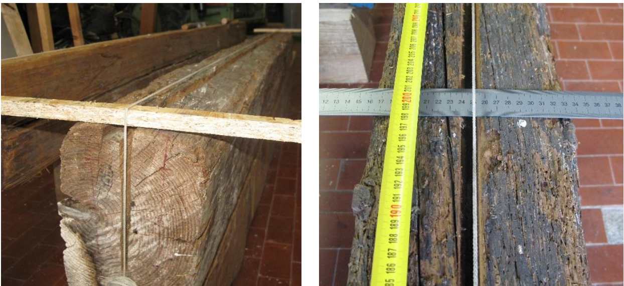
Figura 17 – Posizionamento del filo da muratore e tracciamento delle linee di taglio (trave T09).
