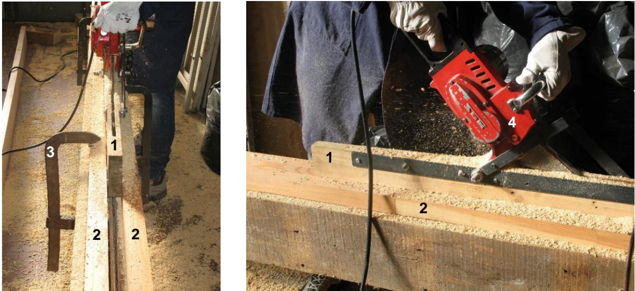
Figura 18 – Esecuzione dei tagli mediante l'elettrosega. Nella figura di sinistra è raffigurato il sistema di guida impiegato tramite l'utilizzo di due quadrotti di legno (2), fissati alla trave grazie a dei morsetti (3), dove all'interno scorre la slitta di legno (1) sulla quale è montata l'elettrosega (4).
