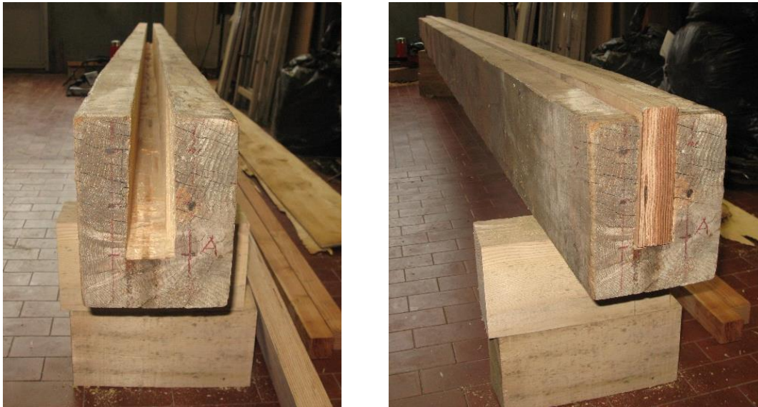
Figura 19 – Trave scavata (T07) (foto di sinistra) e con pannello inserito prima della rifinitura (foto di destra).
