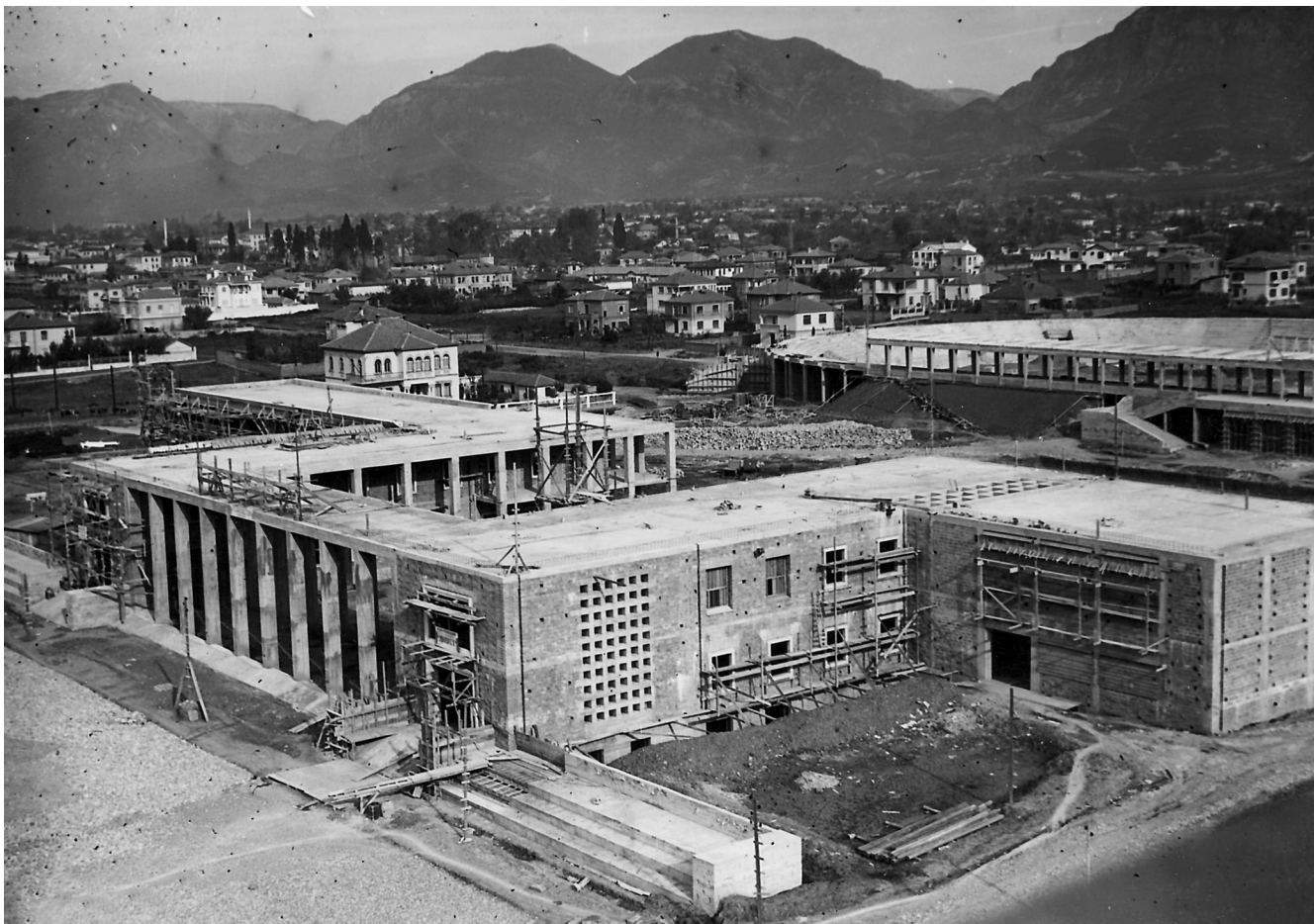
Edificio G.L.A. in costruzione, 1939/40. Foto d'epoca
