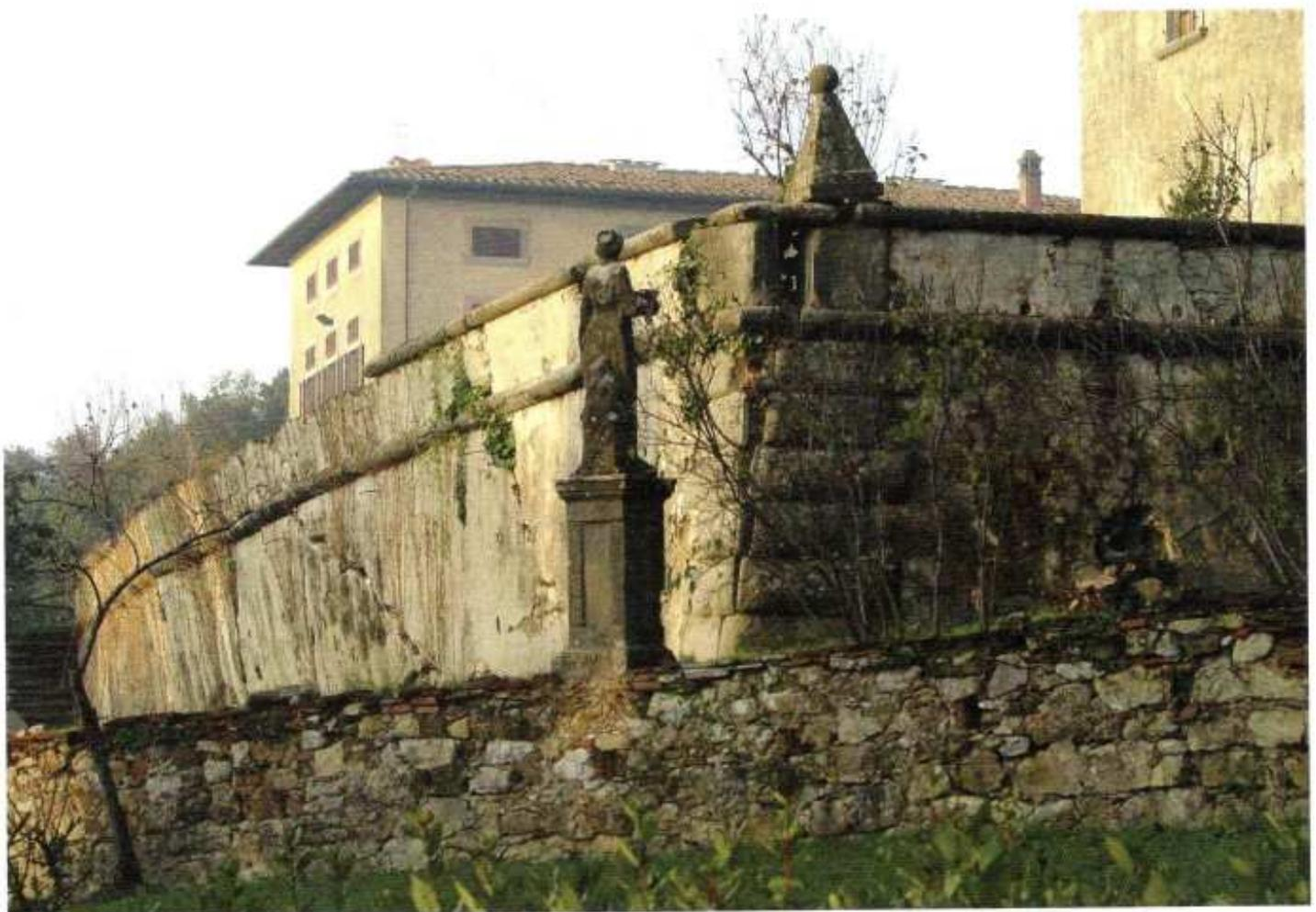
9. Lo stato di degrado statico del muro a retta del grande prato a sud della villa
