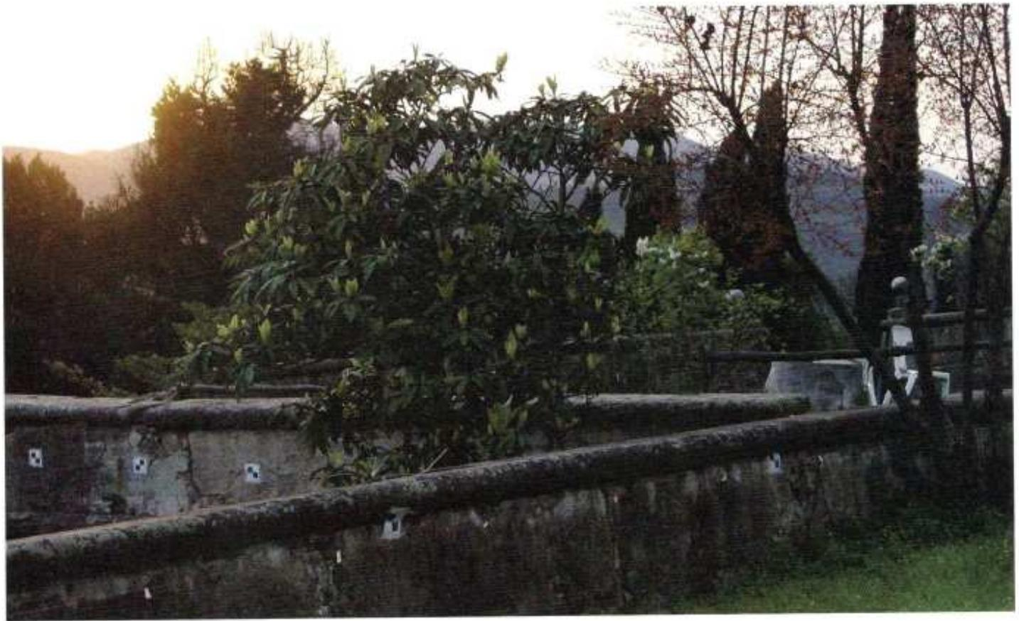
8. Il muro di contenimento del prato a sud della villa, con le mire per il rilievo fotogrammetrico
