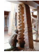
19 Ejemplo de consolidación agresiva del contrafuerte
