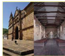
24 Iglesia de santa Lucia fachada e interior
