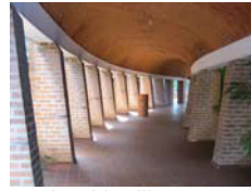
18 Grietas del Pasillo
