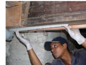
9 Puesta en obra de la lámina con componente biadesivo
