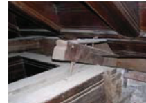
4 Consolidación de emergencia ente tirantes apareados y canes (1869)
