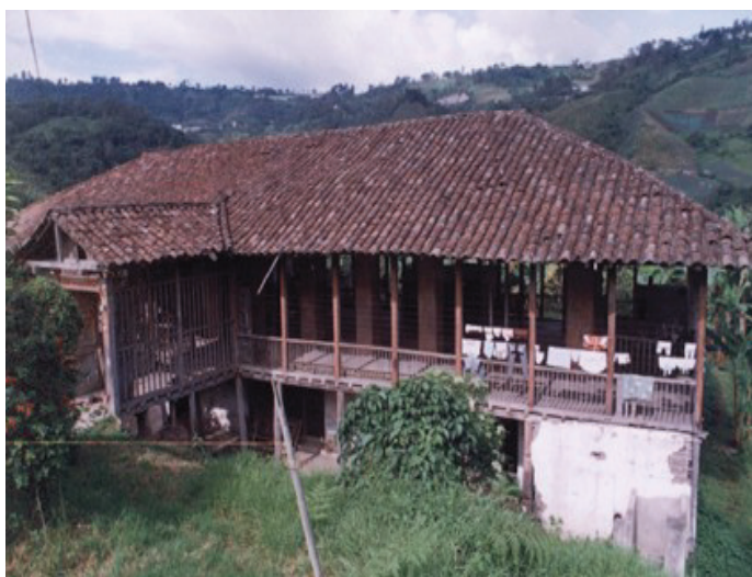
Figura 5: Estilo Temblorero con Bahareque de Tabla- T4. Primera Trilladora de Café: El Arenillo - 1894. Manizales. PCC
