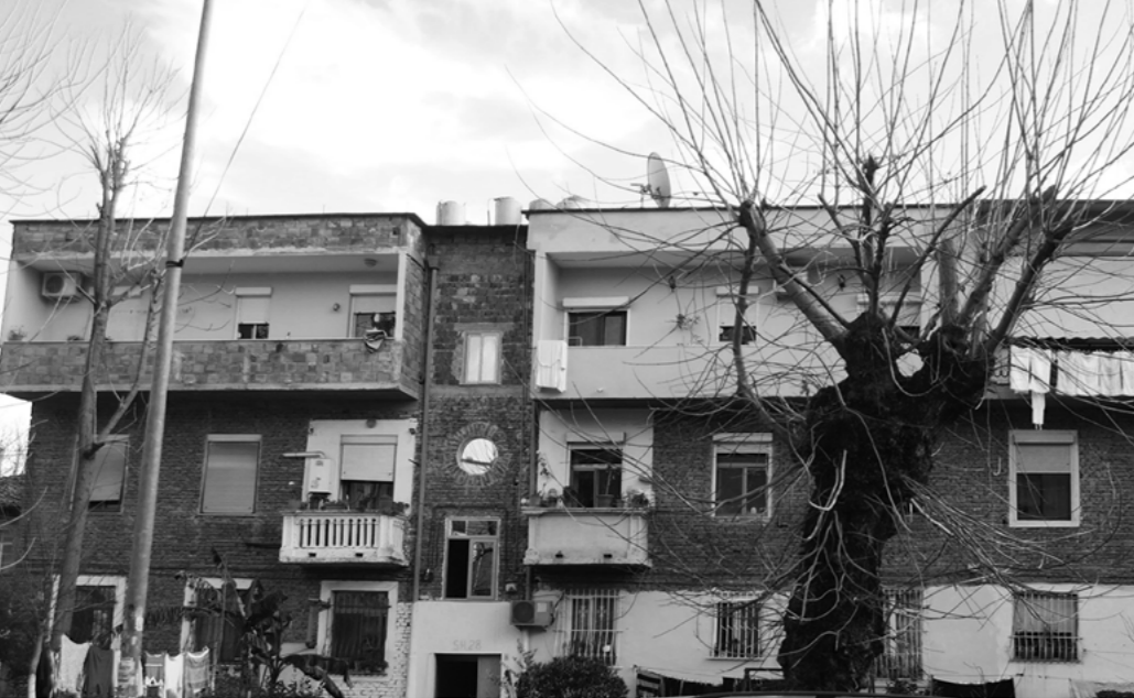
Quartiere 1 Maji, edificio residenziale su corte interna
