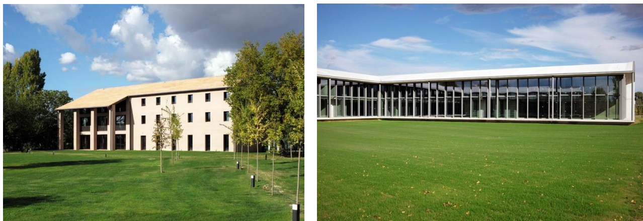
Fig. 53 - H-Farm 2, il primo step del progetto H-Campus costruito nel comune di Roncade. (Fonte: foto dell'autore).
