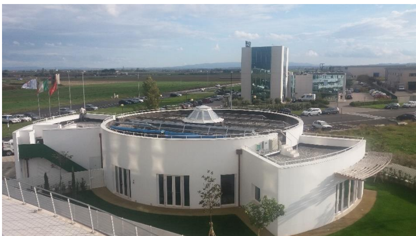
Fig. 42 - Il nuovo centro educativo costruito all'interno dell'area. Il terreno e l'edificio, sono stati donati gratuitamente al Comune di Pisa. (Fonte: foto dell'autore).
