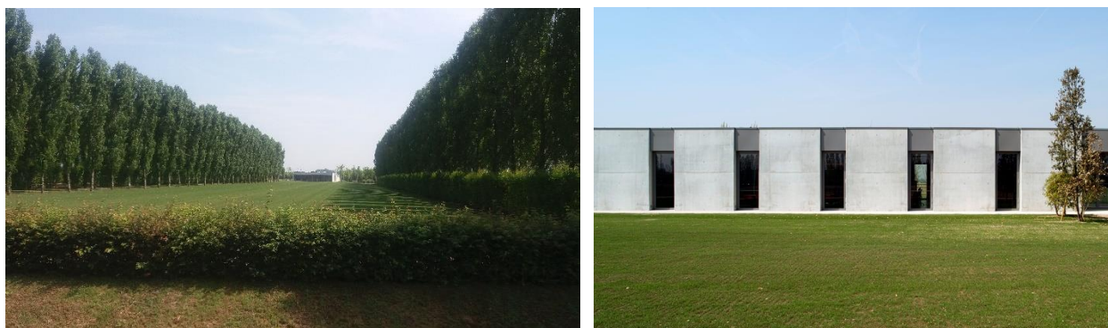
Figura 50 - Il recupero di una cascina abbandonata in cui ora ha sede H-Farm. (Fonte: foto dell'autore).
