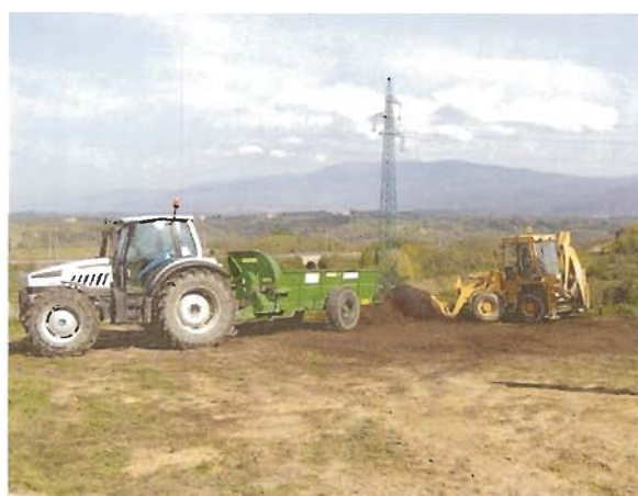
10. Cantiere di lavoro
