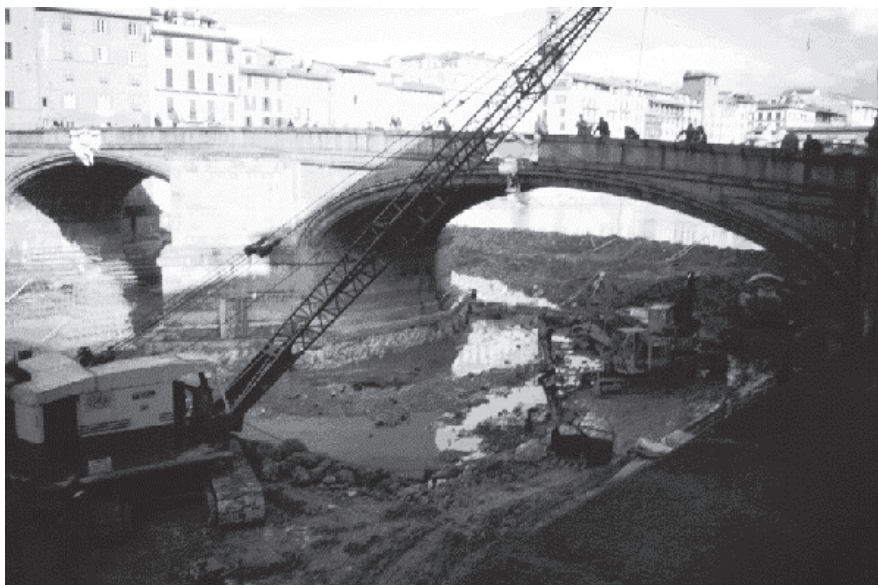
Foto dei lavori di abbassamento della platea del ponte a Santa Trinita nel 1981.
