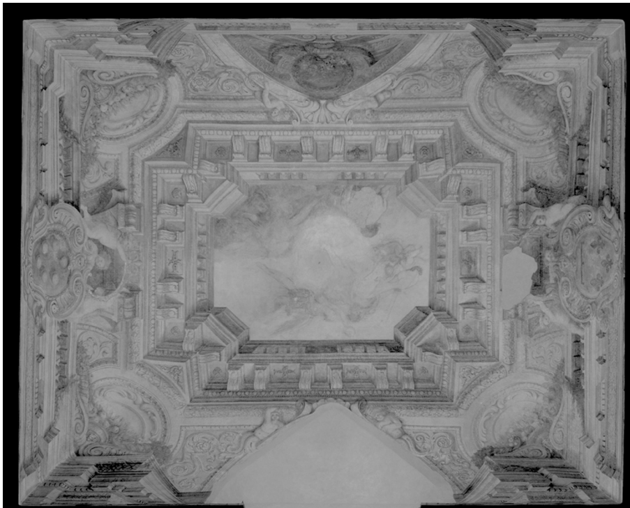
2. la snapshot della nuvola di punti nella proiezione della sezione orizzontale della volta
