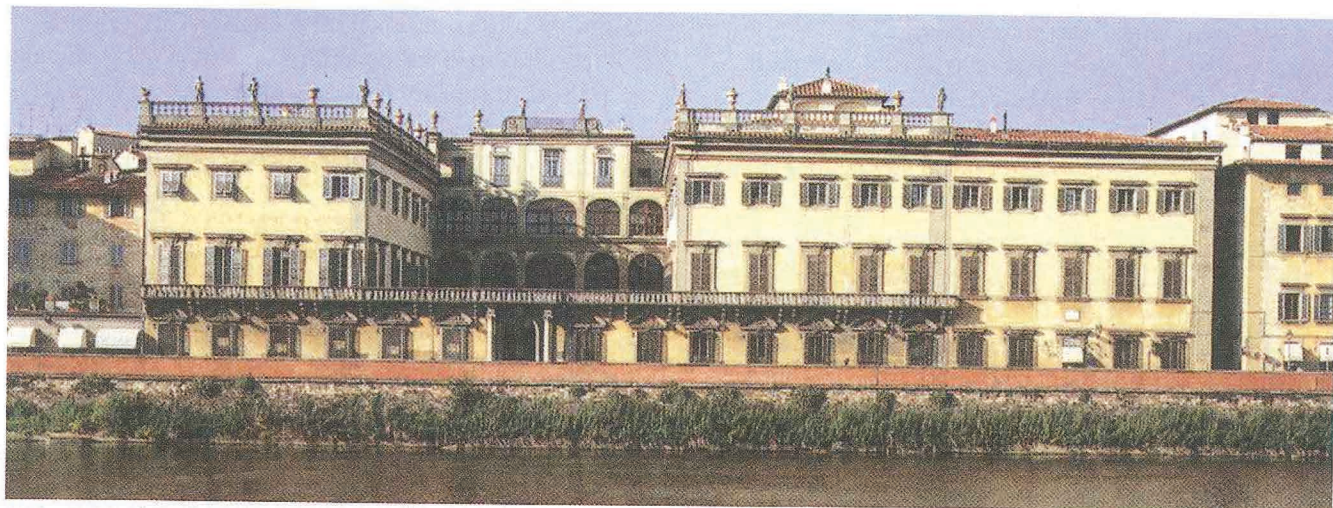
5. Il palazzo Corsini, la facciata sul lungarno: la terrazza a balaustra da accesso al cortile decentrato rispetto all'edificio e in rapporto scenografico col fiume
