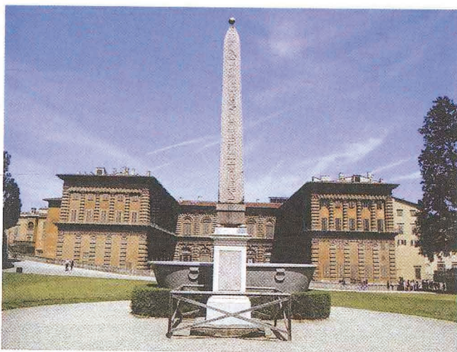
3. Il palazzo Pitti, l'articolazione spaziale del fronte sul giardino
