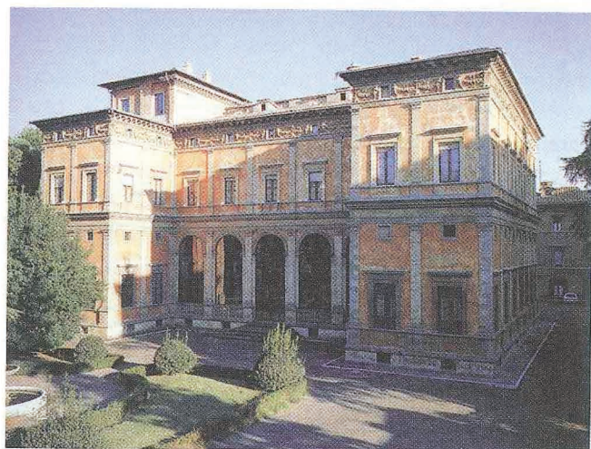
4. La Farnesina, il fronte meridionale con la Loggia di Psiche
