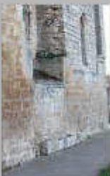
Tracce preesistenti di un arco ogivale. L'arco ogivale è stato restaurato con mattoni e calcina. M. 20 x 20 x 20
