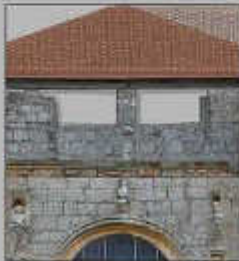
Interno della chiesa absidato prima dell'opera di restauro
