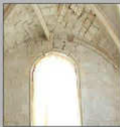
Interno della chiesa absidato prima dell'opera di restauro
