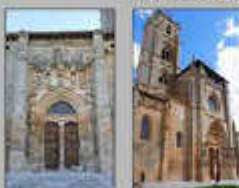
Altri prospetti del perimetro della Cattedrale
