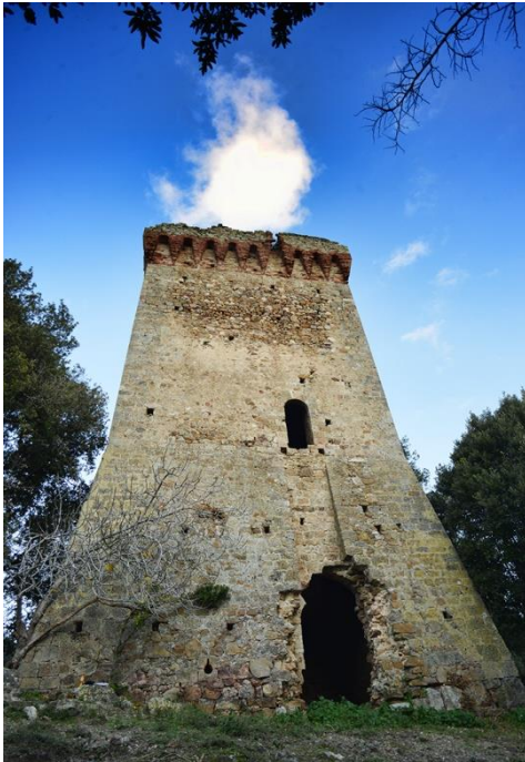
Fig. 2- Vista dal basamento della Torre Bassa (G. Verdiani, 2017)
