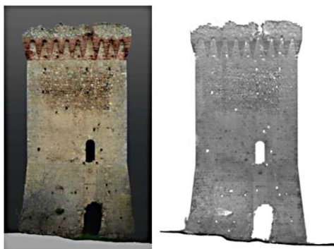
Fig. 5- Resa da nuvola di punti e fotopiano del fronte ovest della torre (M.V. Salvatori, 2017)
