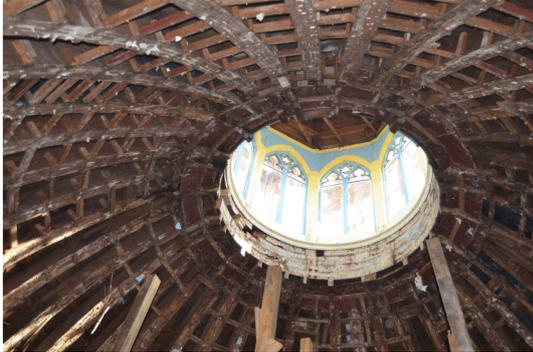
Fig. 2 Esqueleto de la cúpula
