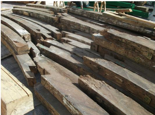
Fig. 3 Cuaderna desmontada a pie de obra
