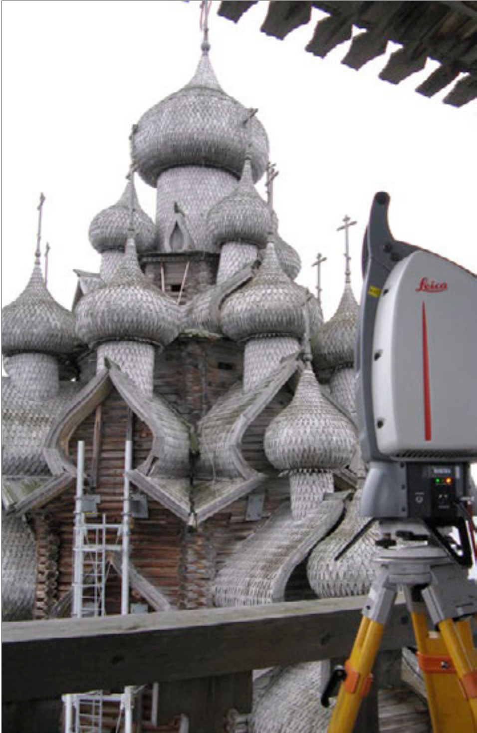
Fig. 109. Campagna di rilievo laser scanner del Complesso della Pogost. © Sara Porzilli 2010
