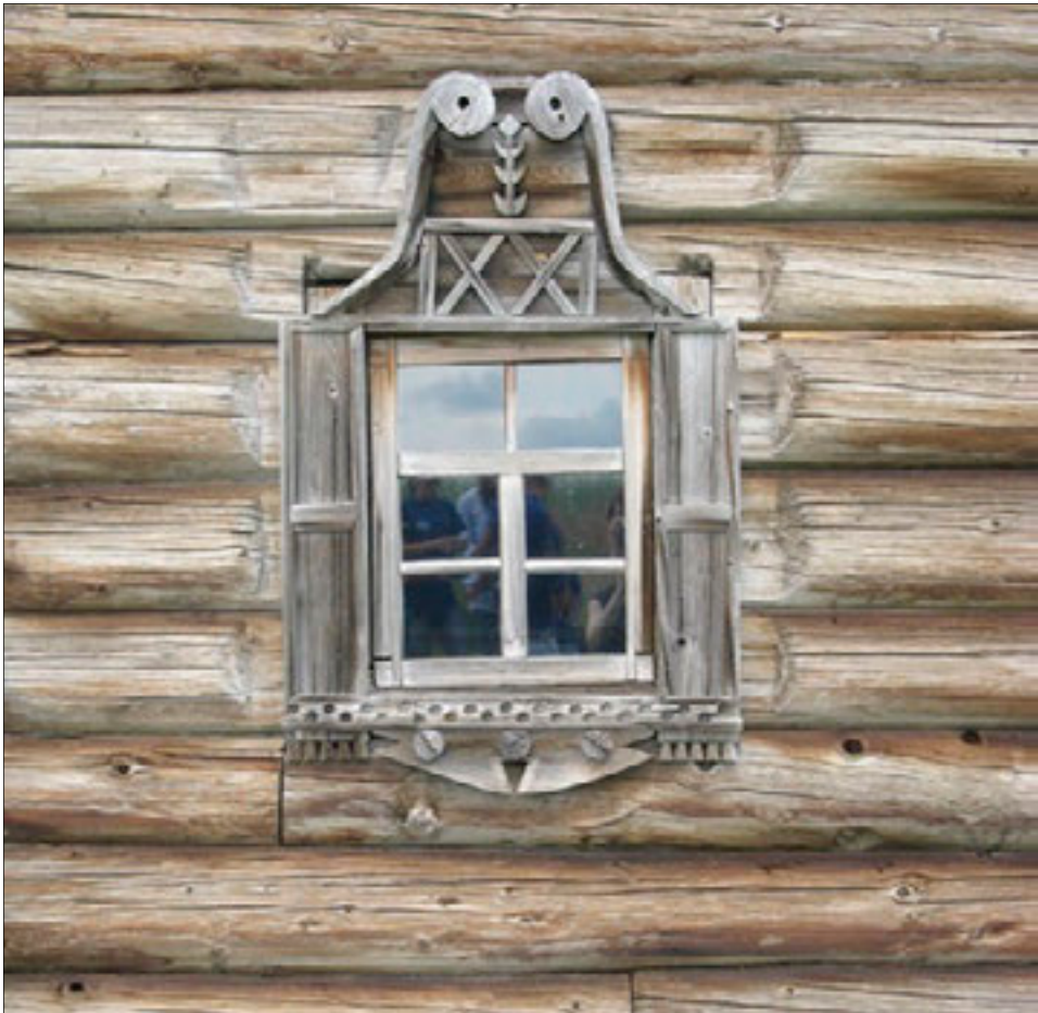
Fig. 26. Particolare di un'abitazione careliana con i tipici telai caratterizzati da lavorazioni artigianali nelle quali si riscoprono forme amorphe, protrettrici della casa. © Sara Porzilli 2013
