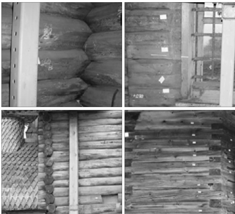
Fig. 12. Disegni di studio e immagini di incastri a block-bau con differenti finiture degli angoli. Dettagli della Chiesa della Trasfigurazione di Kizhi in Carelia, Russia. © Sara Porzilli 2013
