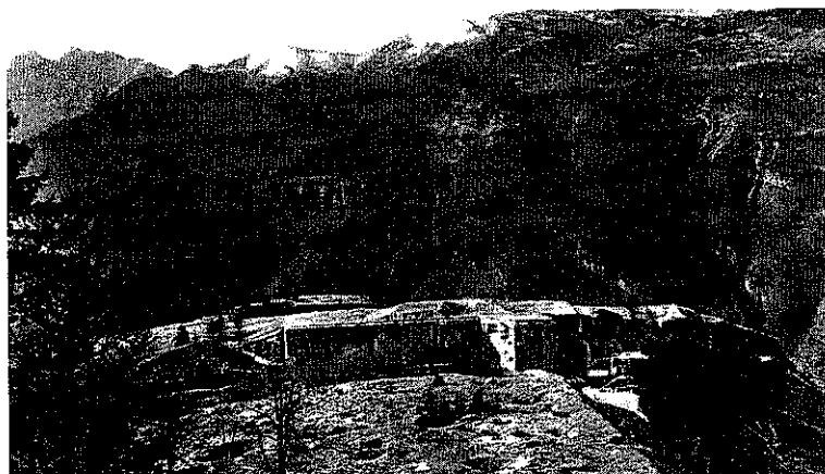
Fig. 5. Forte Belvedere. Foto storica.
