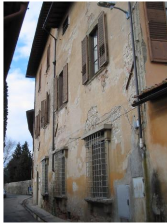
Fig. 2. Esempio di edificio cui potrebbe essere applicato l'isolamento a cappotto esterno con un buon rapporto costo-beneficio in virtù dell'estremo deterioramento della stessa
