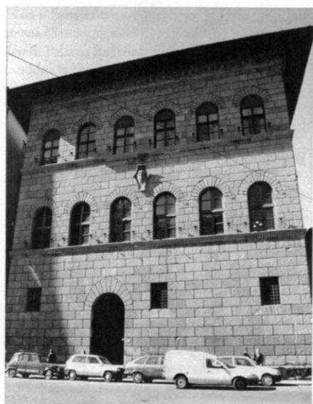
Fig. 5 Palazzo Antinori, fronte sulla piazza. Il paramento lapideo del fronte appare come un apparecchio perfettamente isodomo con lo stesso trattamento a bugna piatta a tutti i livelli.
