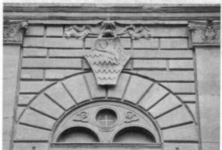
Fig. 6 Particolare di una delle finestre di Palazzo Rucellai.
