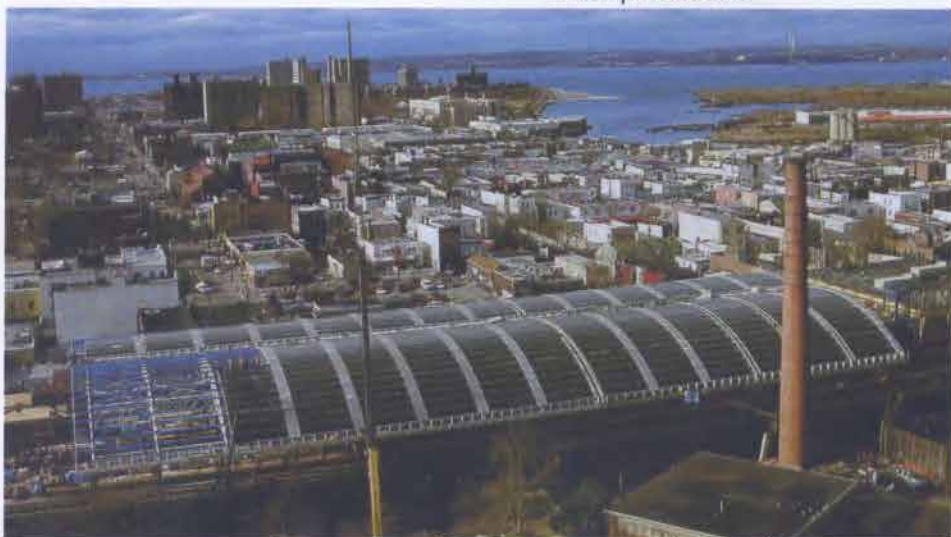
6. La struttura in ferro e i vetri semitrasparenti dei moduli FV lasciano passare molta luce naturale nelle piattaforme
