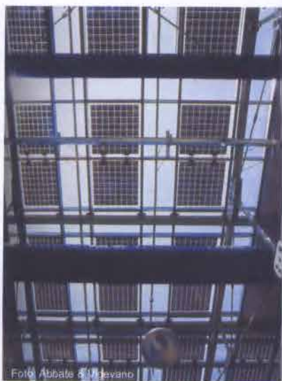
1 Vista della copertura integrata con un lucernario FV vetro/vetro 2,3 Vista dell'interno del museo 4,5,6 Viste delle pensiline FV
