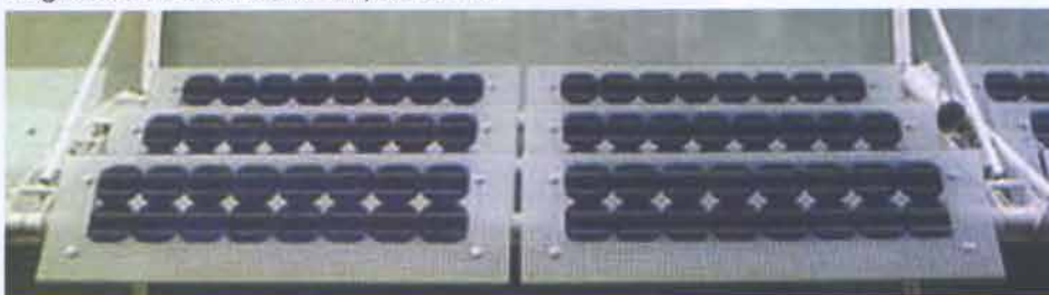
2,4 particolare dei frangisole Fv 3 sezione con la posizione dei frangisole FV
