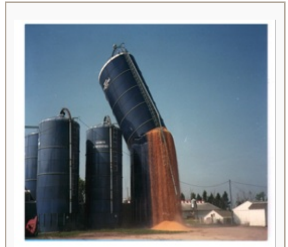
Figura 8. Rotura de un silo
