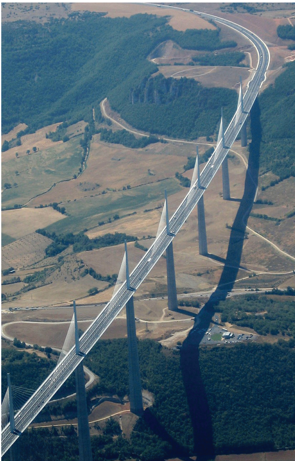
Norman Foster con Michel Desvigne, Viadotto di Millau, Francia
