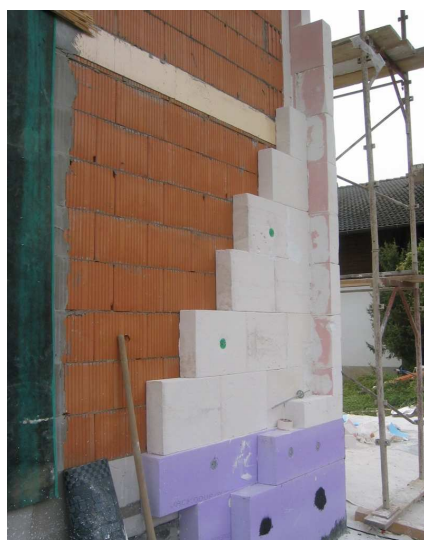
Figura 1 - Coibentazione della casa passiva Blasbichler a Verdings (BZ) (foto G. Gantioler)
