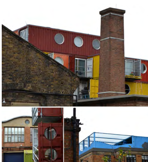
Figura 2 – Container City, nella penisola di Trinity Buoy Wharf a Londra, appare al visitatore come un laboratorio in scala reale sulle potenzialità d'impiego del container come strumento per 'occupazioni informali pianificate'. Ambiti espositivi, spazi per eventi, servizi, laboratori, alloggi/studio per giovani ed artisti, sono realizzati accatastando container: ora accanto alle ciminiere, ora sopra i magazzini, ora all'interno dei capannoni un tempo abbandonati.
