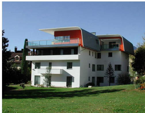
Figura 6. Vista complessiva dell'edificio [7]
