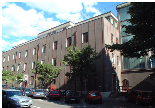
Figura 7. Veduta dell'edificio ex-posta prima del retrofitting energetico [7]
