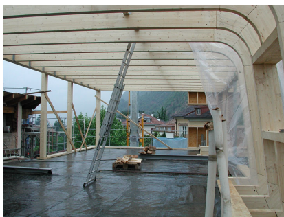
Figura 5. Immagine della fase di cantiere della sopraelevazione. Progetto Arch. M. Tribus [9]
