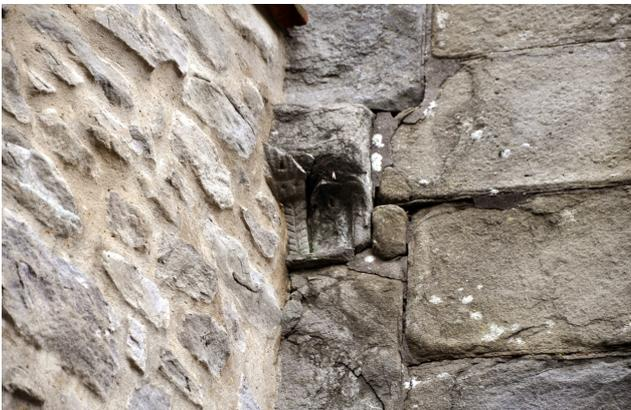
Fig. 10 - Mensola a sostegno dell'architrave dell'accesso (B) parzialmente inglobata in una struttura muraria
