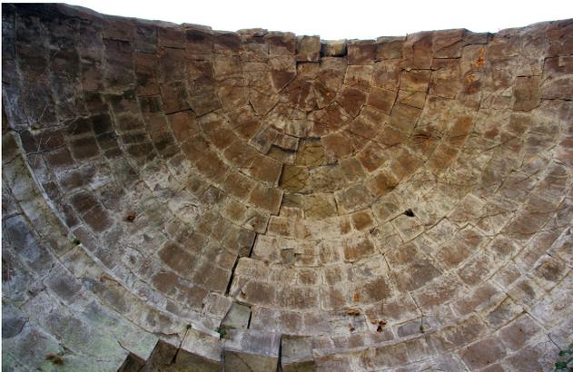
Fig. 8 - Catino absidale realizzato con buona cura stereotomica
