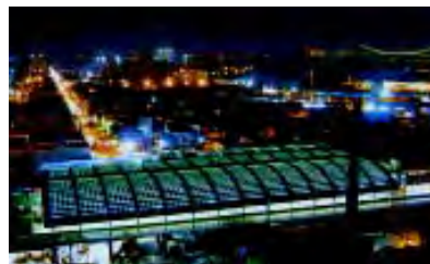
1. Vista notturna della copertura FV
