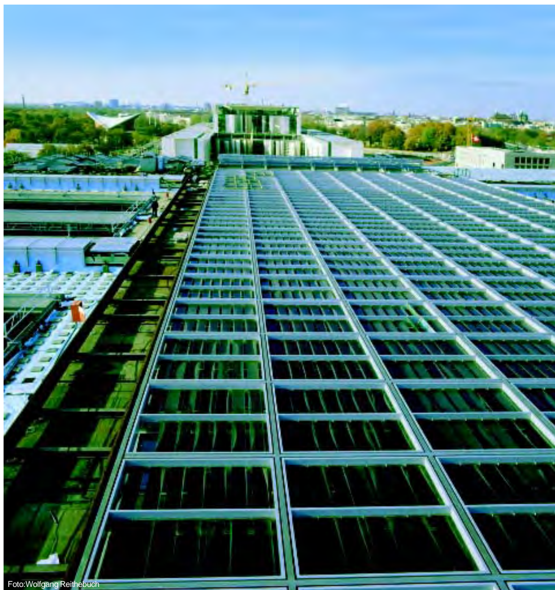
4 Vista del 5,6,7 Viste e particolare delle lamelle frangisole FV in posizione aperta e chiusa
