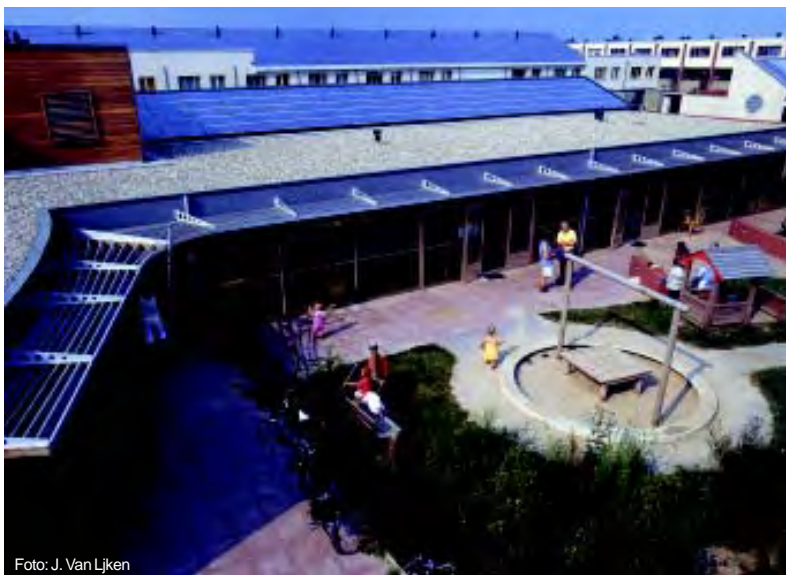
1,2 Viste dall'alto della scuola e dell'impianto FV inclinato a 20°
