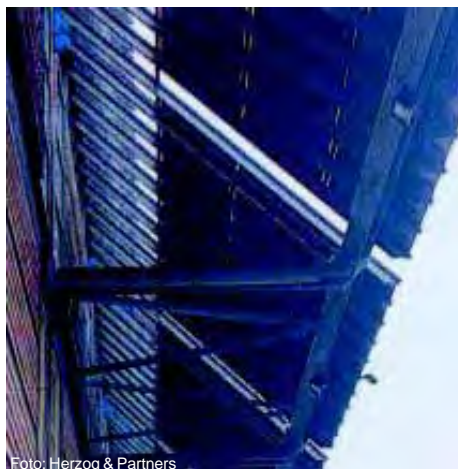
1,2 Vista dei frangisole FV lato Sud 3 Vista prospetto ovest
