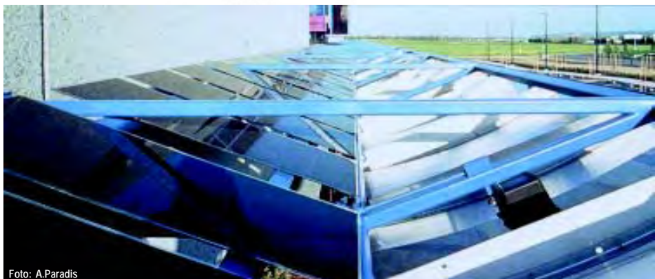
10 Vista della struttura di sostegno della pensilina FV
