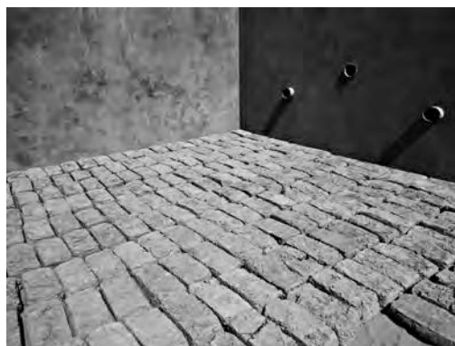
Vista interna ed esterna di alcune classi in costruzione (foto FAREstudio)
